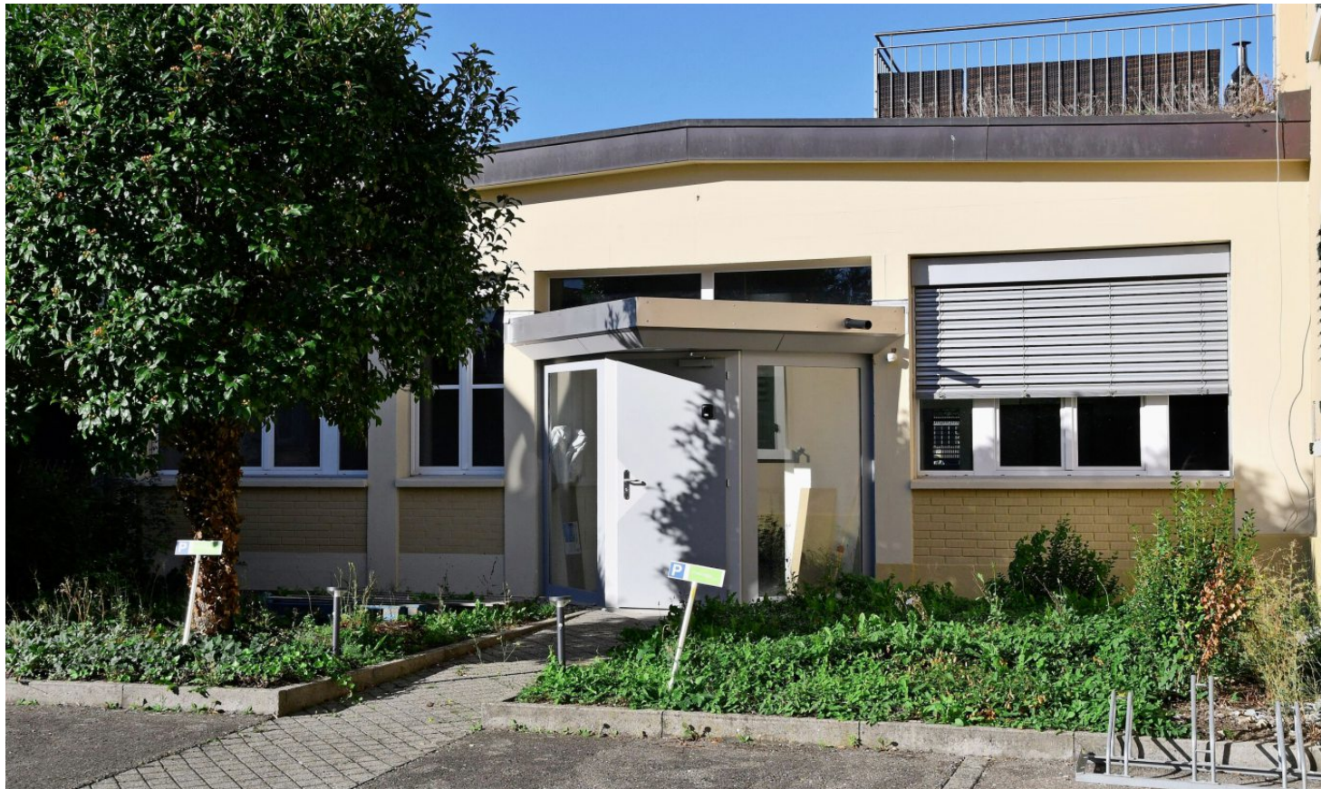
Der Zugang zum Schulzentrum der Peregrina-Stiftung befindet sich an der Steinackerstrasse in Sulgen.
