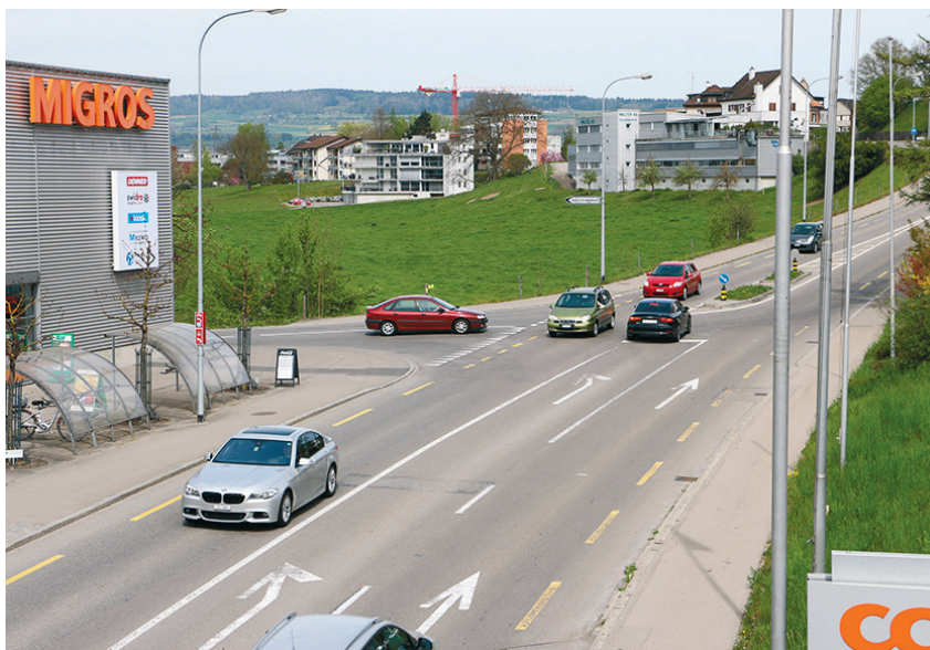
Durch bauliche Massnahmen soll der Verkehrsfluss beim Abzweiger Hauptstrasse/Industriestrasse verbessert werden.
